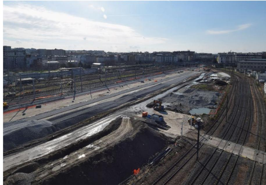
Sur la partie ferroviaire, les travaux nécessaires à la suppression et aux modifications des voies ont été réalisés. Ils permettent de libérer les espaces nécessaires pour créer les voies principales du CDG Express et les accès à la liaison technique afin que l'exploitant puisse remiser les trains.
